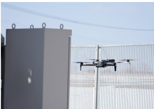
【変電所構内を LTE ※2 で飛行する様子】
