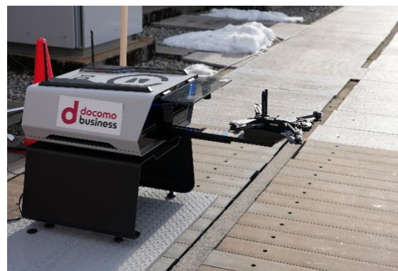
【変電所構内の自動巡視開始前の様子】
